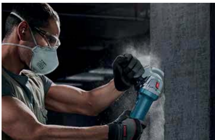
Rezanje betona
